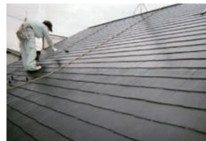
工場のスレート屋根の改修工事です。築30年ほど経過。スレートの劣化により漏水も疎らです。またアスベスト含有も懸念されます。高圧洗浄後SKY-SPを浸透させ、石綿繊維の固化と止水処理を行い乾燥させます。次にスカイコートを塗布、この成分中にセラミック中空ビーズが混練りしており、乾燥させことで断熱効果が増幅されます。乾燥後にスカイコートシルバーで遮熱保護します。スカイコートシルバーの撥水効果により雨のたびに屋根を洗浄して銀色の保護効果は長期的に継続します。
