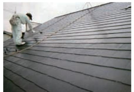
工場のスレート屋根の改修工事です。築30年ほど経過。スレートの劣化により漏水も疎らです。またアスベスト含有も懸念されます。高圧洗浄後SKY-SPを浸透させ、石綿繊維の固化と止水処理を行い乾燥させます。次にスカイアポロMXを塗布、この成分中にセラミック中空ビーズが混練りしており、乾燥させることで断熱効果が増幅されます。乾燥後にスカイアポロシルバーで遮熱保護します。スカイアポロシルバーの撥水効果により雨のたびに屋根を洗浄して銀色の保護効果は長期的に継続します。
