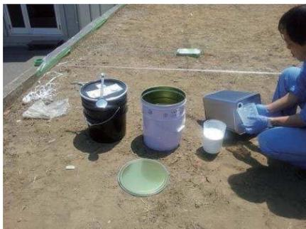
施工準備。SKY-RGHを水で10倍に希釈。希釈率により乾燥時間、乾燥時の堅さが変わる。(参考希釈と参考塗布量)
