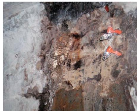
けい酸塩系表面含浸剤の主たる成分は珪酸ナトリウム、珪酸リチウム、珪酸カリウムなどと添加剤または混和剤からなり、元素周期の1族アルカリ金属に属します。これらはコンクリート躯体内に浸透し、アルカリシリカ反応を起こした空隙で、水酸化カルシウムと反応ゲル化し、空隙を充填緻密化し、不足した強度を補うことが出来ます。
