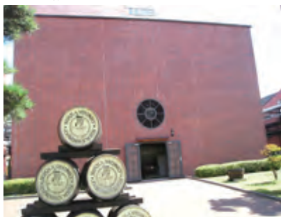
外壁タイルの補修保護工事
