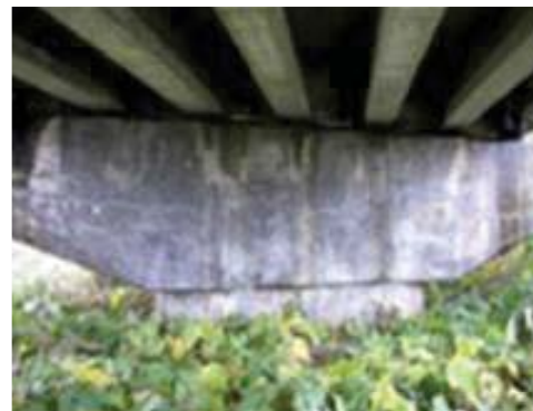
アルカリ骨材反応の事例(亀甲状ひび割れ)
