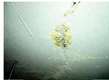
下の階の漏水状況
