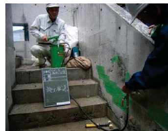
アクリル板張り付け後、ケミカルポンプでSKY-SP先行注入、ついでハイドロフィット特殊注入材充填
