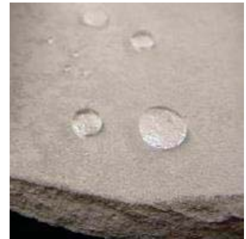
コンクリート面の撥水状況
