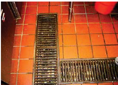
グレーチングの直下に漏水
