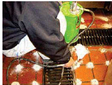
穿孔した孔に SKY-CSP+ SKY-G1 ペーストを注入
